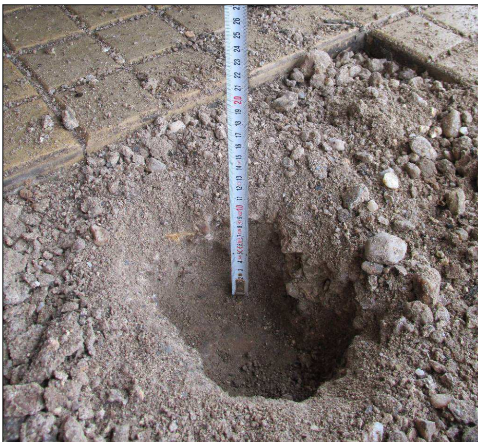
Obr. č. 7 - detail sondy do konstrukce - silně zdegradovaný podkladní beton
