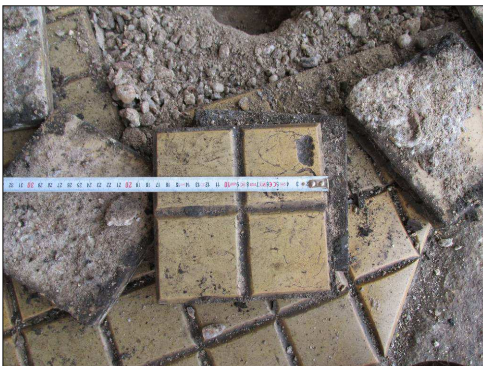
Obr. č. 8 - detail dlažby - rozměry 17,7 x 17,7 x 3,0 cm
